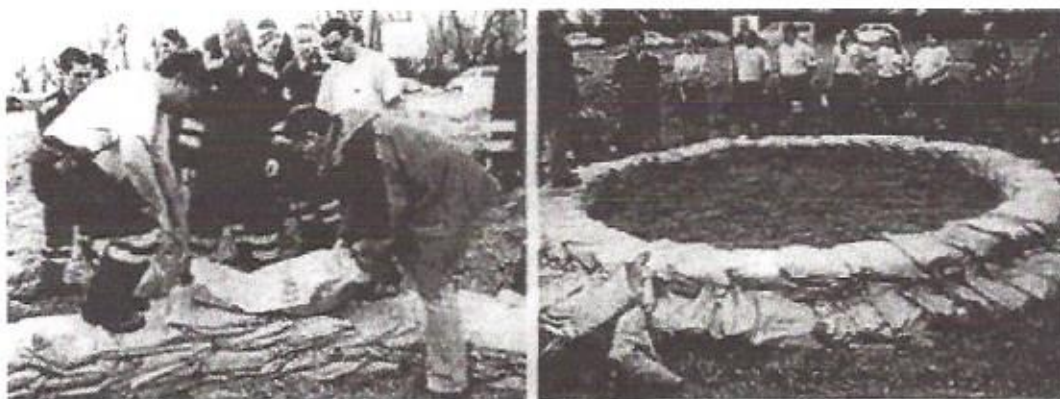
6. sz. képcsoportok: A buzzár ellennyomó medencéjének kiépítése
