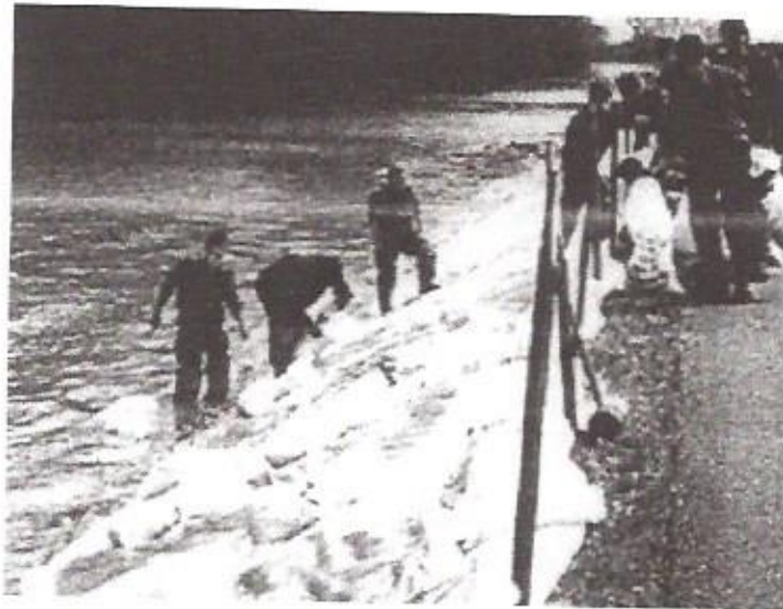
Hullámverés ellen biztosított homokzsák nyúlgát
