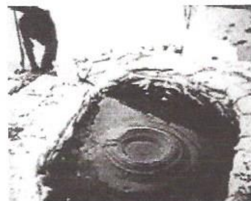
5. sz. képcsoportok: A buzgár kiépített ellennyomó medencéje
