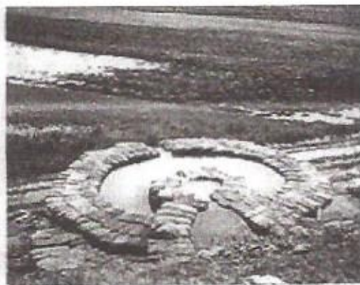
5. sz. képcsoportok: A buzgár kiépített ellennyomó medencéje
