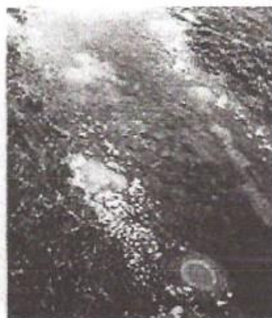
2. sz. kép: Buzgár csoport. Védekezés a jelenségek összevonásával, szorítógáttal.
